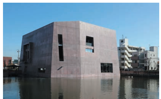
日射制御の観点から窓は全体の壁の11%しかないが、開口を大きめにするなど工夫が施されている(写真:KAI NAKAMURA)
