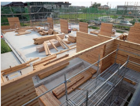
「ICK」施工現場
