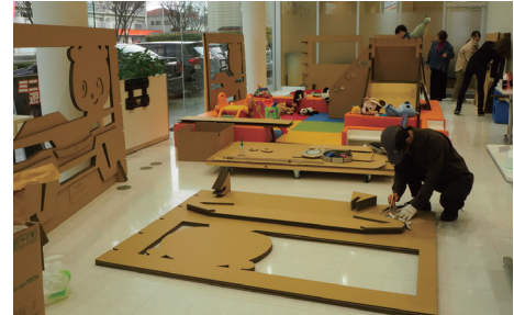
現地での組み立て作業風景 1つ1つを手作業でボンドだけを使い施工していきます
