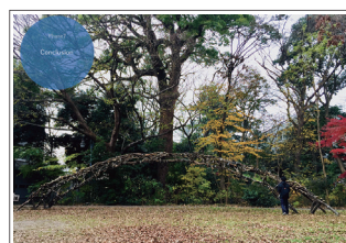
キャンパス内に完成した全長16mの橋
