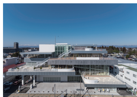
各階のスラブをずらして重ねることでテラスや吹き抜けを作り、人々の活動が見えるようにした
