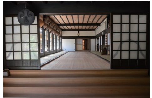
庫裡内部改修後。
