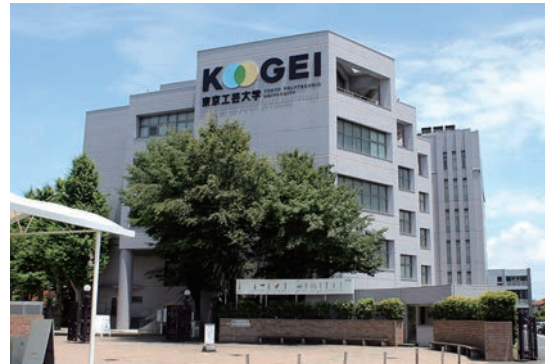
神奈川県厚木市の豊かな自然に囲まれた17万平方メートルの広大な敷地の東京工芸大学 厚木キャンパス。
