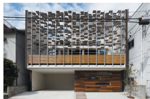
プライバシー対策と気化熱による自然空調を兼ねたファサードのセラミックパネル(写真: © DAICI ANO)
