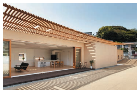
日影シミュレーションの結果に基づいて開口部の位置を決めた木製の吊り屋根(写真: © 中村 絵)
