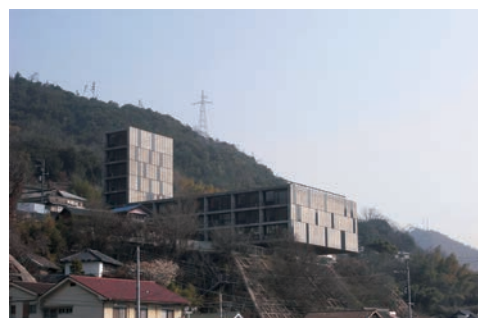
広島県尾道市の傾斜地に建つ「Seto」。崖の上に建物が12mほどオーバーハングしている
