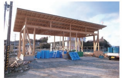
建て方が終了した構造部材
