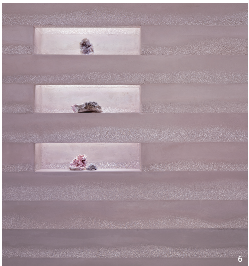
下から上へ行くにつれて彩度が明るくなっていくよう17色の左官材をつかって調整したグラデーションの壁。壁の白く粒立っている層が、骨材が露出した部分
