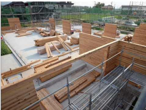
「ICK」施工現場
