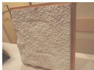
洋服の質感をモチーフにデザインした吹きつけ断熱材による内装
