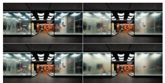
1階プロモーションスペースを囲うガラスの壁。オンオフで印象がガラリと変わる
