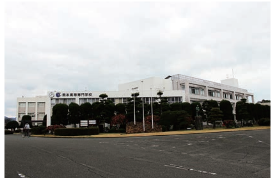
熊本県八代市に位置する熊本高等専門学校八代キャンパス。写真右側3階建て校舎が研究対象の1年生から3年生の教室がある共通教育科棟。
