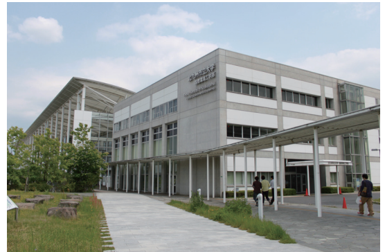
2001年に開設した国際環境工学部のある、北九州市立大学ひびきのキャンパス。
