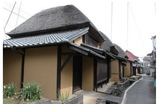
佐賀県鹿島市、肥前浜宿「浜庄津町浜金屋町重要伝統的建造物群保存地区」の修復が終わった茅葺きの町家。
