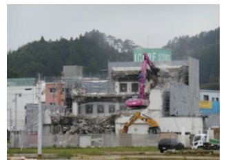
宮城県気仙沼市内のビル解体工事
