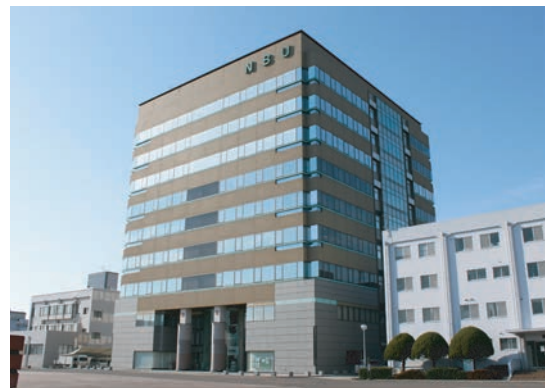
大分市の自然豊かな41万㎡の広大な敷地に位置する日本文理大学。「インテリジェントキャンパス構想」に基づき設置されたNBU情報センター（正面）にはCAD室が入る。
