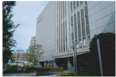
オーデリック株式会社 本社ビル。設計部門をはじめ、ショールームが完備され、さまざまな照明器具の実物を見ながら詳細に検討することも可能だ。
